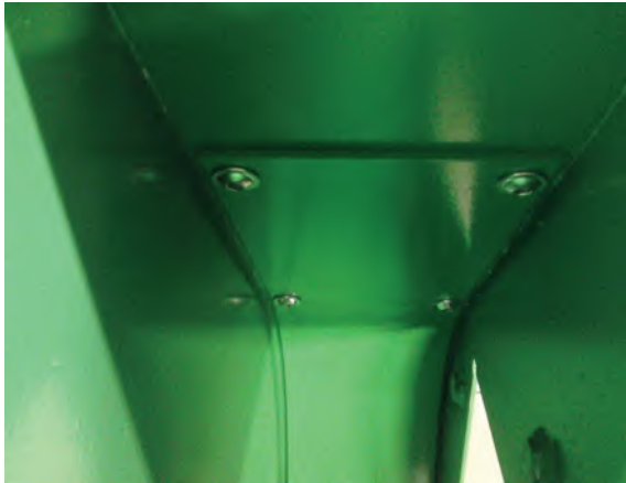
Hardox-Verschleißschutz im Turbinengehäuse
